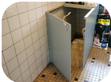
Caisson VMC côté cave avec bouche d'extraction en 125
