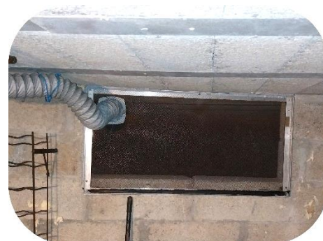
Prise d'air du vide sanitaire et sortie VMC côté cave
