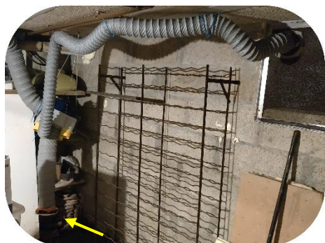
Caisson VMC côté cave avec bouche d'extraction en 125
