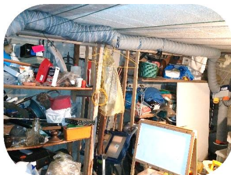
Conduit évacuation VMC circulant au plafond de la cave
