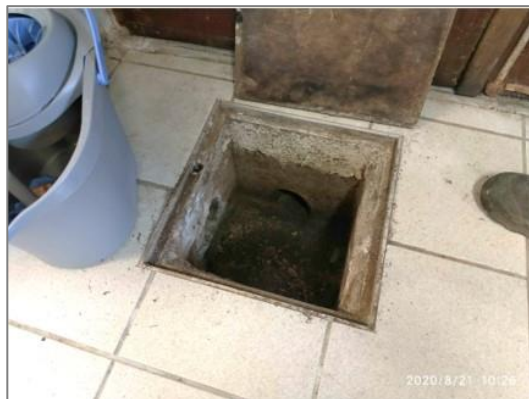
Exemple de trappe et regard nécessitant un étanchement
